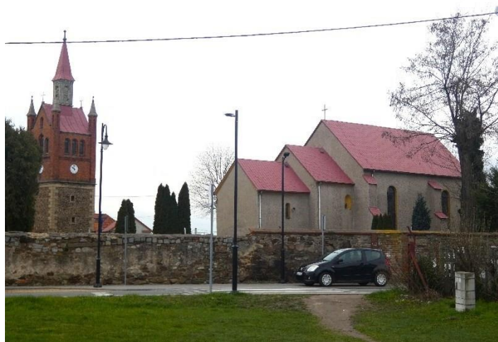
Fot. 1. Łągowniki – widok na zespół kościoła (element zespołu ruralistycznego)
