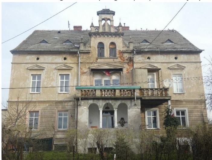
Fot. 10. Budynek mieszkalny w Łagiewnikach z k. XIX w.
