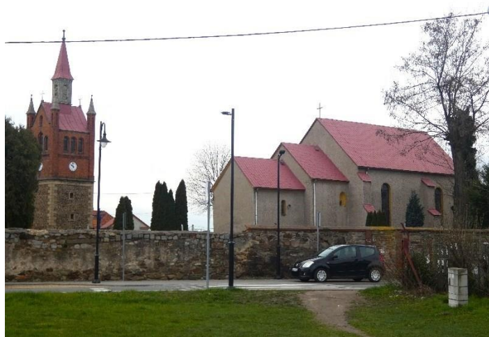
Fot. 1. Łagiewniki – widok na zespół kościoła (element zespołu ruralistycznego)
