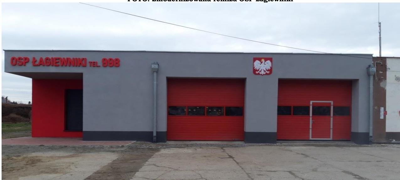
FOTO. Zmodernizowana remiza OSP Łagiewniki
