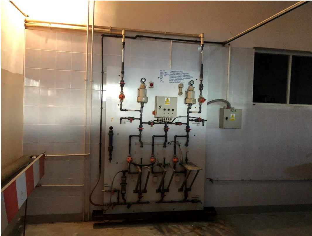
Rysunek 15 Stacja dozowania koagulantu – wyłączona z użytkowania
