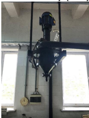
Rysunek 1 Piaskownik - pomieszczeniu krat
