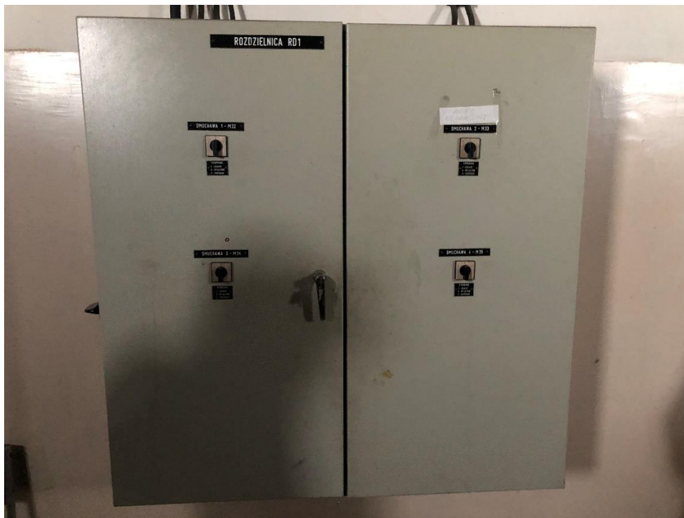
Rysunek 7. Rozdzielnica RD1 - sterująca pracą dmuchaw w ciągu technologicznym oczyszczania ścieków przemysłowych (blok wyłączony z użytkowania)
