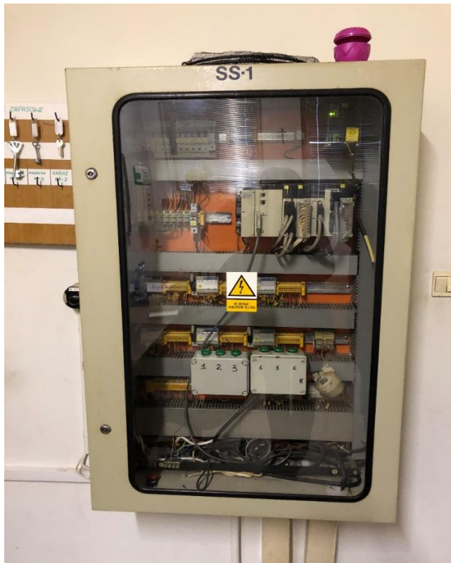
Rysunek 9. Szafa sterująca SS-1 w dyżurce
