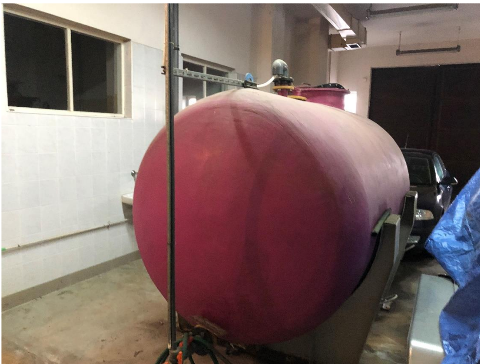
Rysunek 16 Zbiornik koagulantu – wyłączony z użytkowania w UDT.
